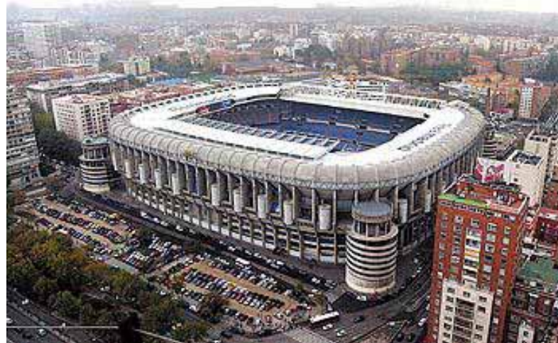
From top: Torres KIO Estadio Santiago Bernabéu
