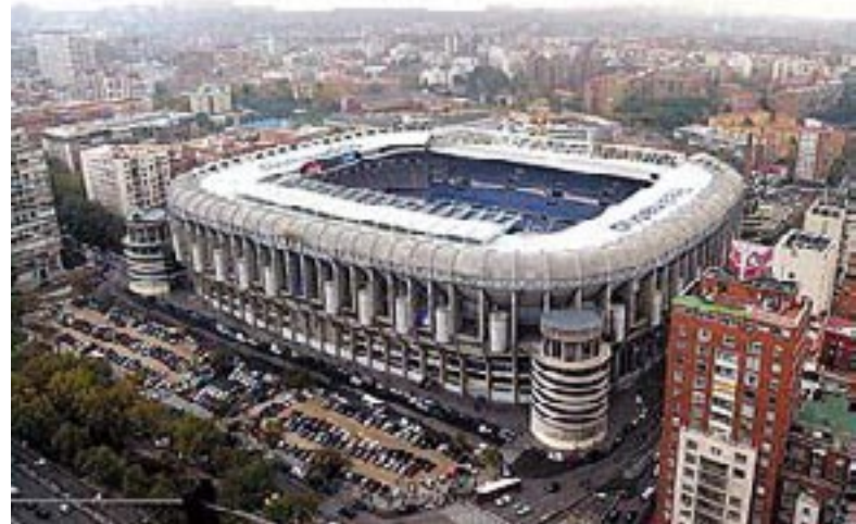
From top: Torres KIO Estadio Santiago Bernabéu
